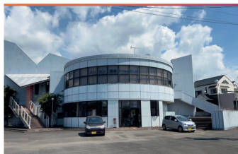
・プライムワークス建物全景
