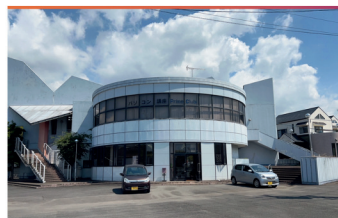
・プライムワークス建物全景
