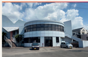
・プライムワークス建物全景
